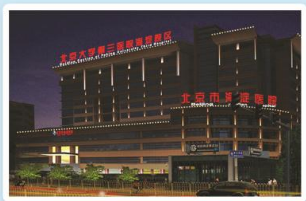
海淀医院门诊、急诊大楼
