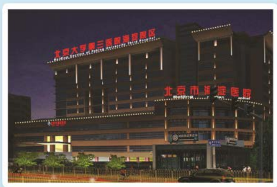
海淀医院门诊、急诊大楼
